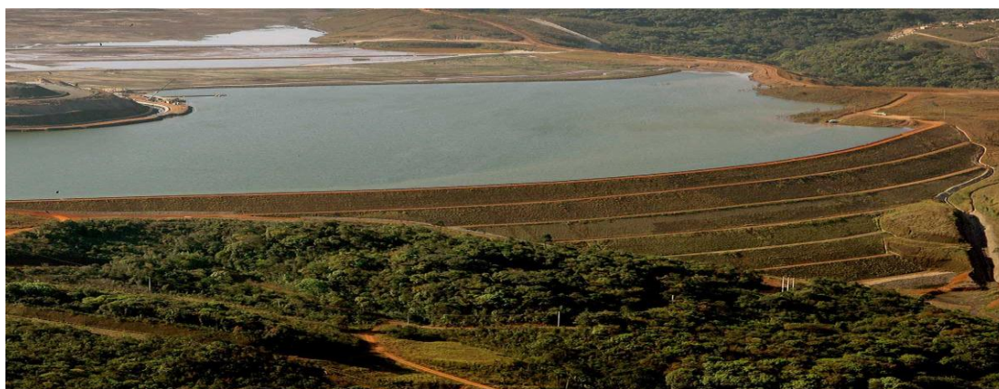
Imagem 04 – Barragem de propriedade da mineradora Samarco em Minas Gerais. Fonte: www.google.com.br/search?q=imagens da barragem da mineradora Samarco .
