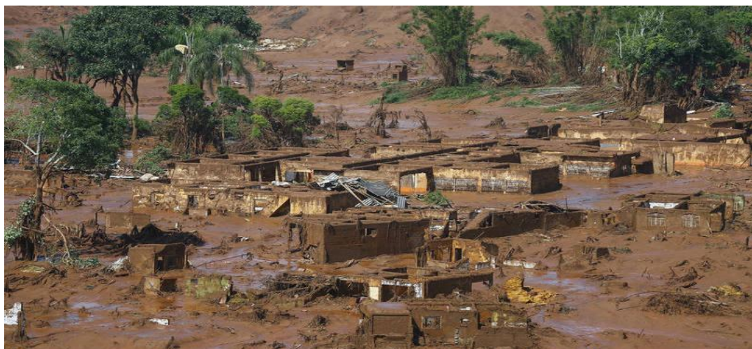
Imagem 01 – Bento Rodrigues destruída pela lama das barragens. Fonte: www.google.com.br/search: rio doce antes e depois .
